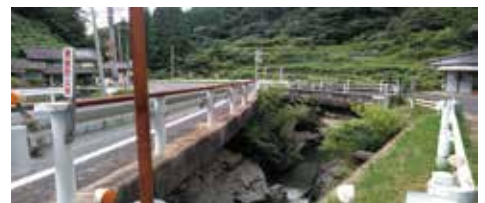
保木上橋（新旧2本の橋がある）
