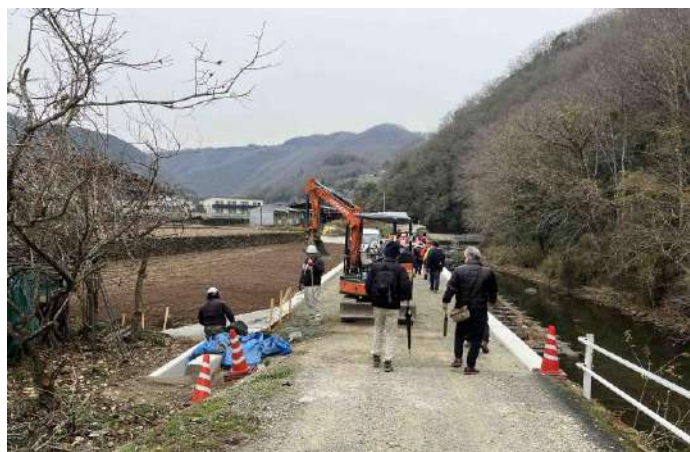
島木川沿いの道の改修工事が進んでいます
